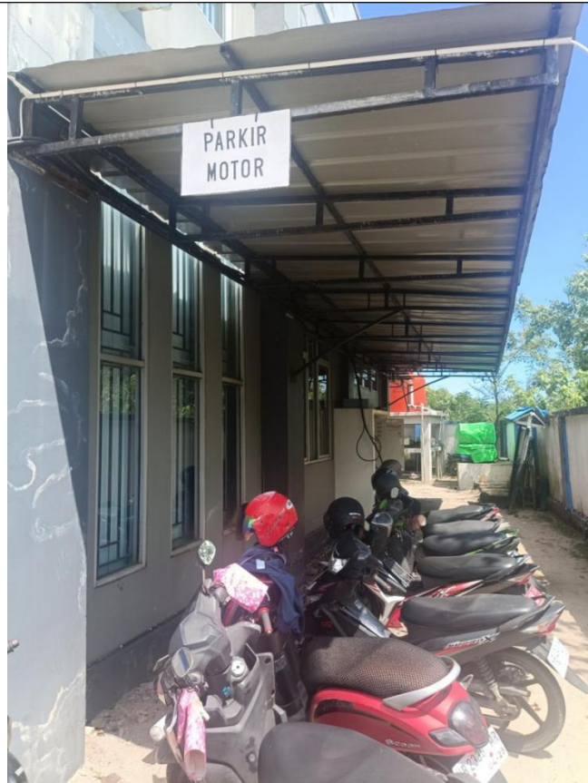
Pelindung kanopi parkir area motor depan
