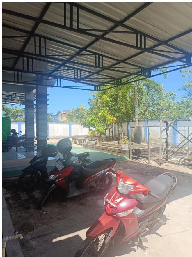
Pelindung kanopi parkir area belakang
